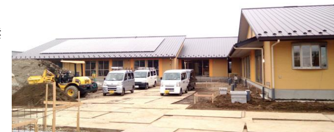
建設中の園舎
