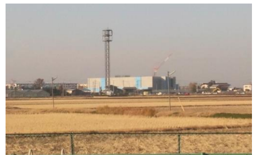
建設中の新病院（カルスタより）
