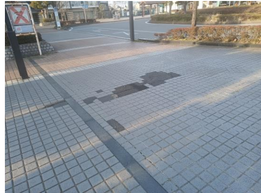
アスファルトで補修する駅前ロータリー
